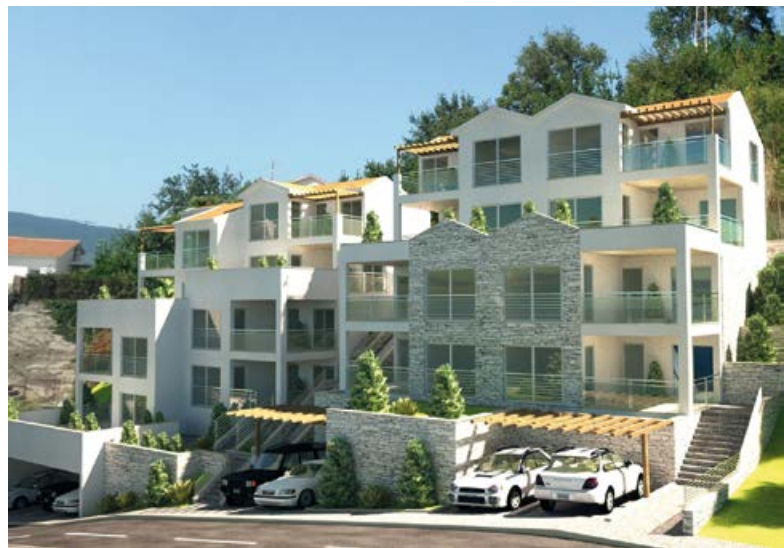
TOPLA, HERCEG NOVI - REALIZOVANO 2012.
