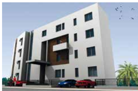
Stambeni objekat „Dollaku”, Ulcinj
