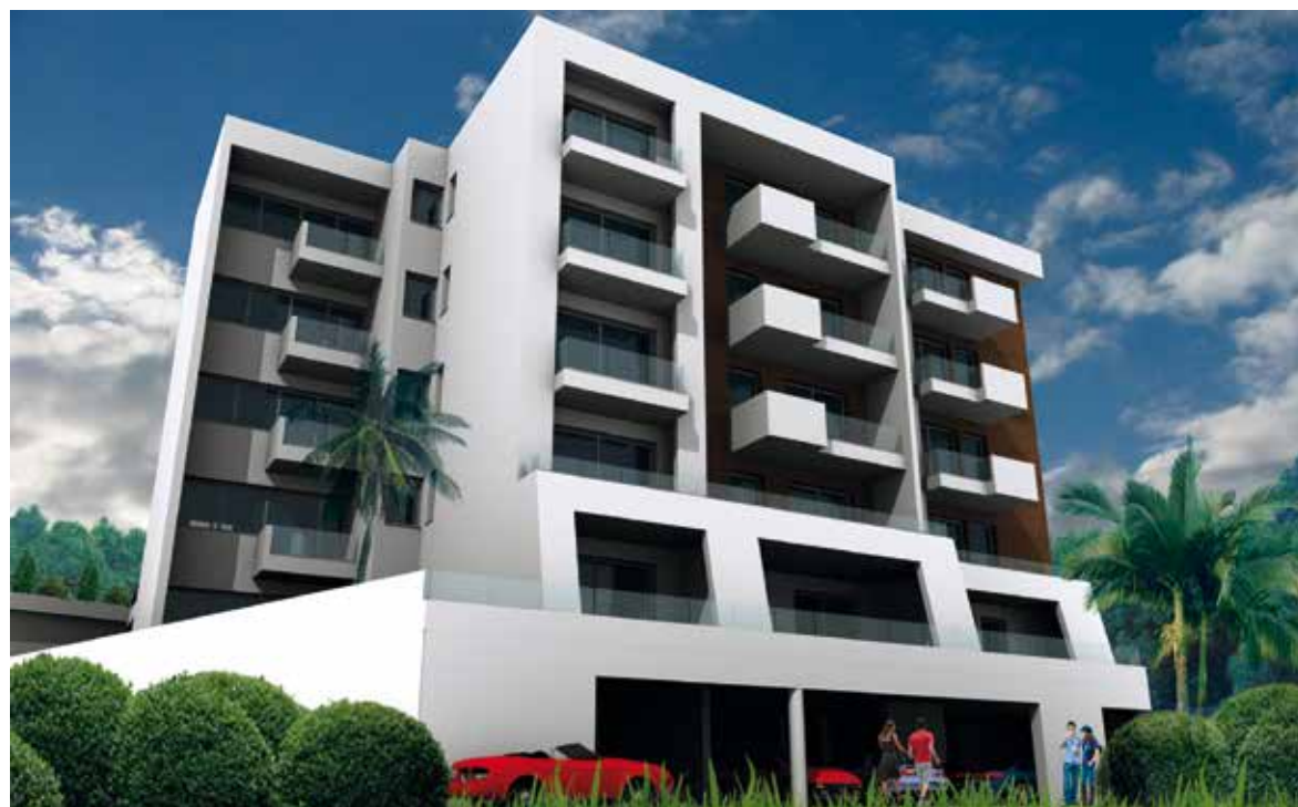
Stambeni objekat „Dollaku”, Ulcinj
