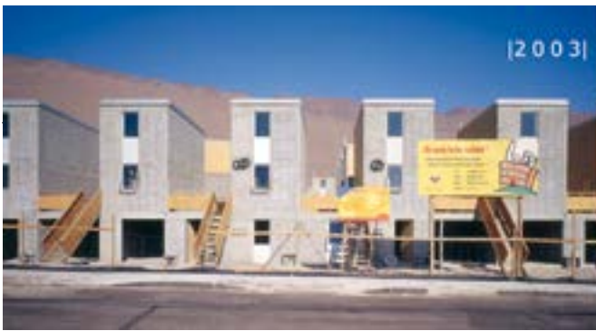
Iquique, Čile: Aravena je osigurao betonski okvir s kuhinjom, kupatilom i krovom (lijevo), a porodice popunjavaju praznine (desno)
