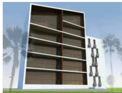
Stambeni objekt „VELA“–Budva
