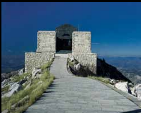
NJEGOŠEV MAUZOLEJ NA LOVCĒNU Sanacija, nadzor, nerealizovan projekat stražarske kuće
