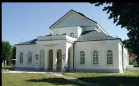
KRALJEVSKO POZORIŠTE "ZETSKI DOM" Cetinje, dogradnja, sanacija, enterijer, nadzor
