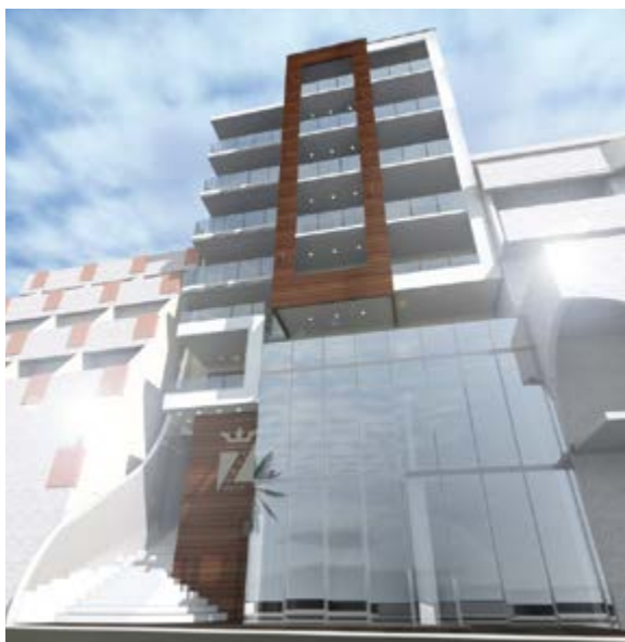
HOTEL (4*), BEČIĆI (RAFAILOVIĆI) / U FAZI REALIZACIJE (2015.)
